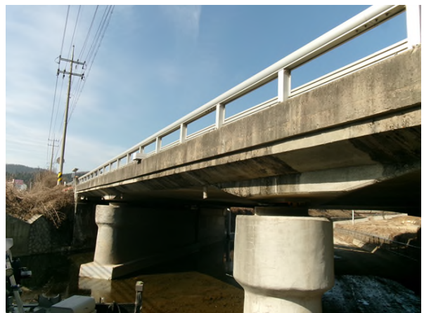
방호벽 외측 전경
