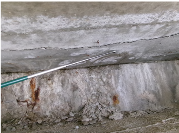
콘크리트 들뜸 작업전경
