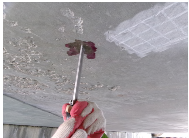
탄산화깊이 측정 현황
