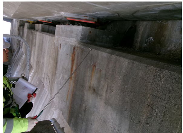
콘크리트 들뜸 작업전경
